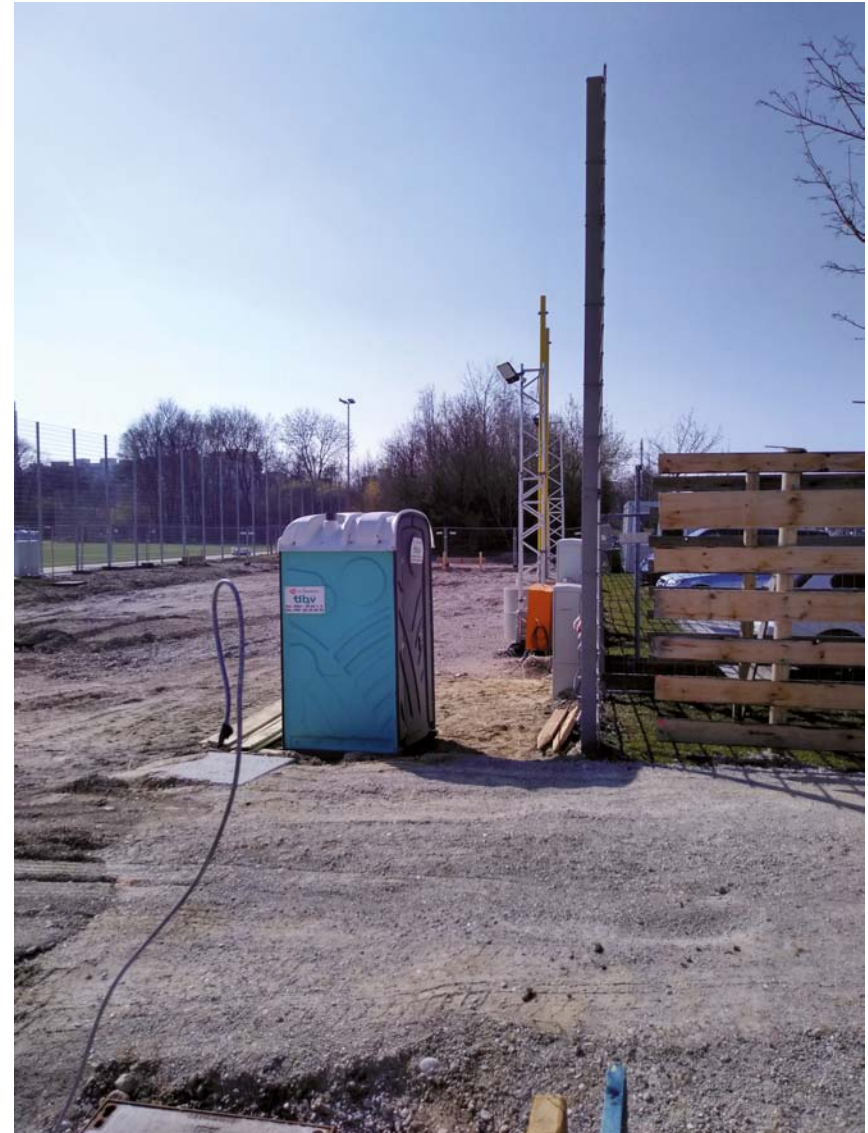
Ein Sportplatz im Bau
